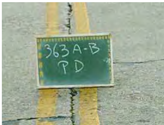
Falha na Selagem das Juntas
