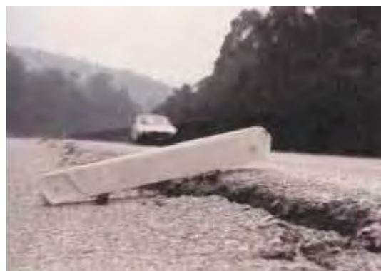
Foto separação entre pista e acostamento
