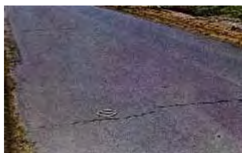
Foto de trincamento transversal
