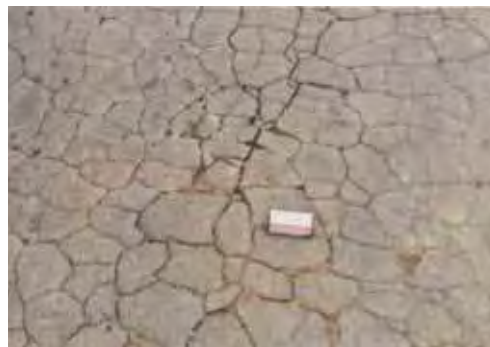
Foto trinca interligada tipo Jacaré
