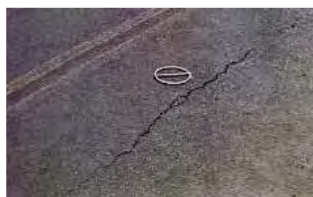
Foto de trincamento longitudinal
