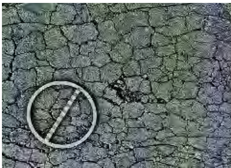
Foto trinca interligada tipo Jacaré
