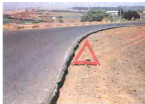
Foto desnível entre pista e acostamento
