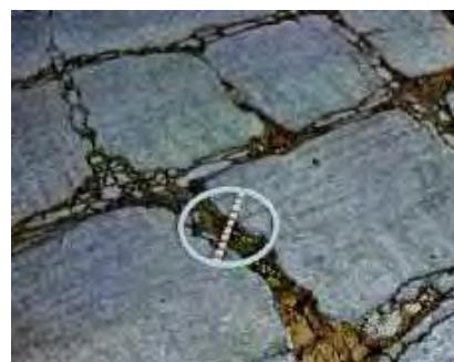
Foto do trincamento em blocos
