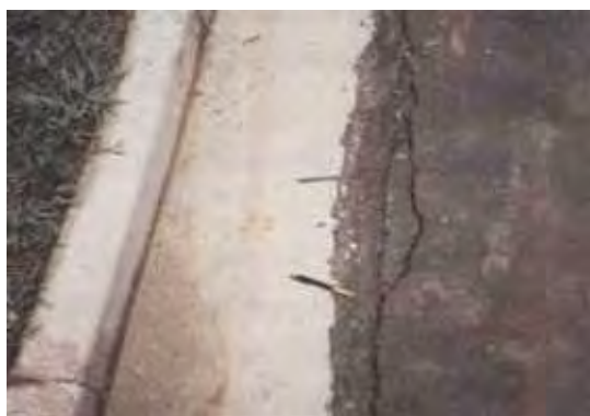
Foto separação entre pista e acostamento
