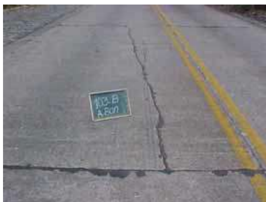
Fissuras Longitudinais
